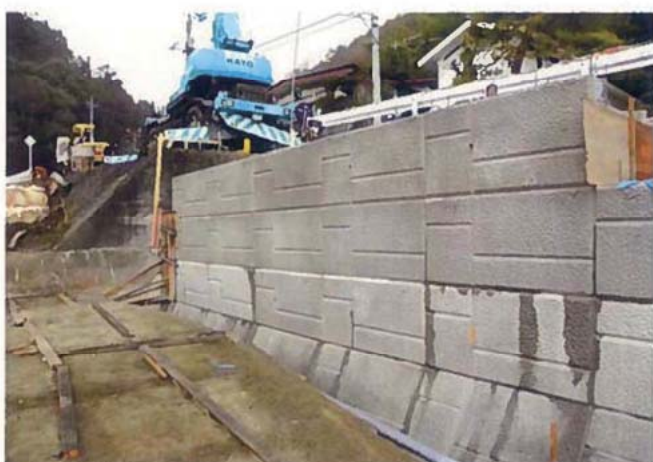
山梨県 (山梨県南巨摩郡 県道平林青柳線)
