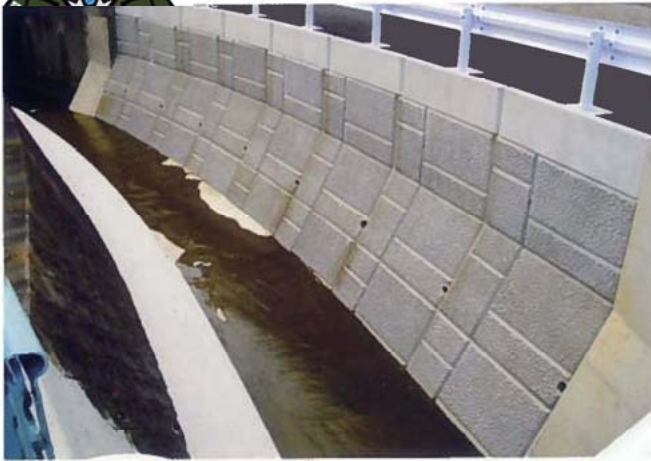
静岡市 (静岡県静岡市)
