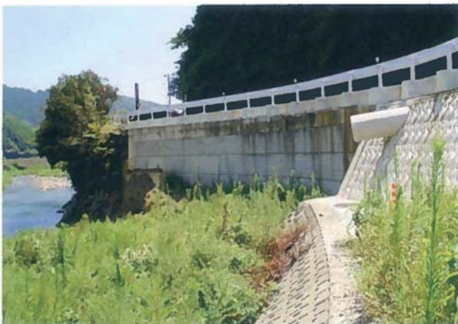
高知県 (高知県室戸市 県道佐喜浜吉良川線)
