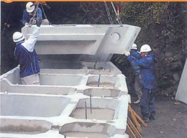
4 段目ブロック据付
