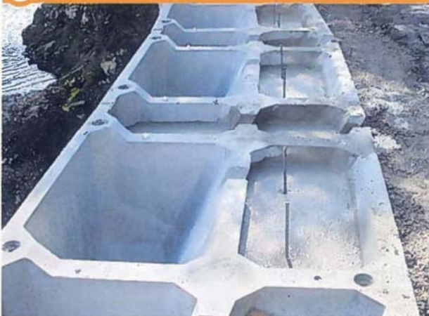
生コン打設状況
