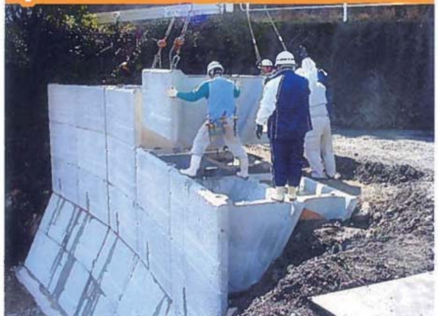
3 段目ブロック据付
